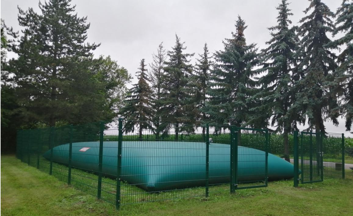
**Abbildung 1: Löschwasserbehälter mit dem Volumen 100 m<sup>3</sup>**
