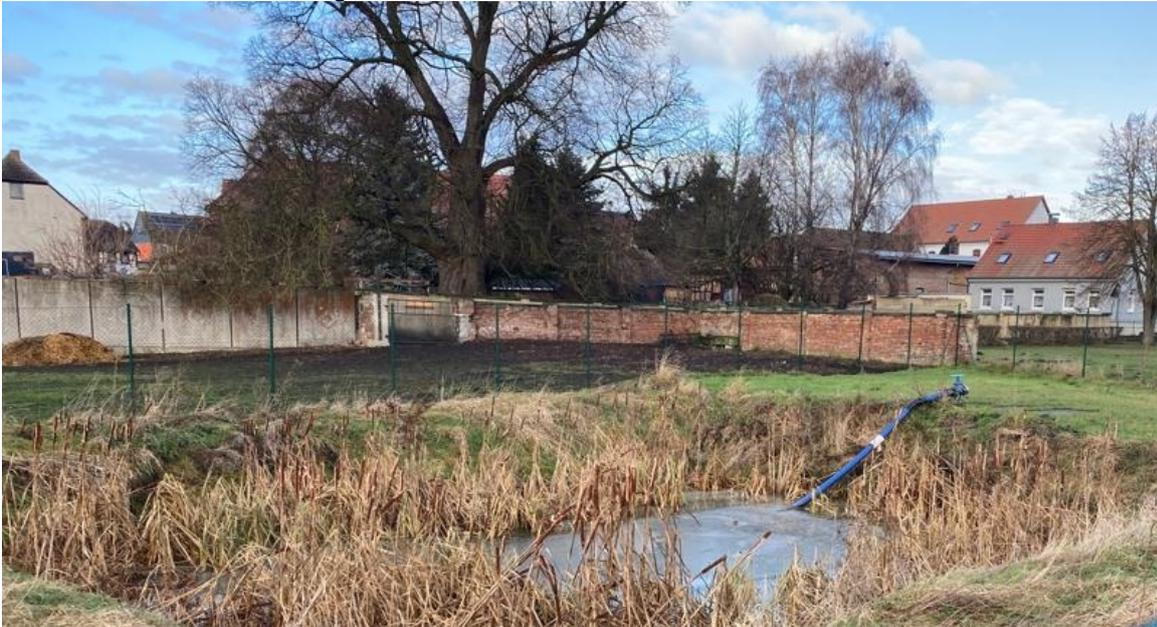
**Abbildung 6: Situation am Löschteich in der Poststraße in Warsleben, der Sauganschluss liegt unmittelbar unter der Wasseroberfläche.**
