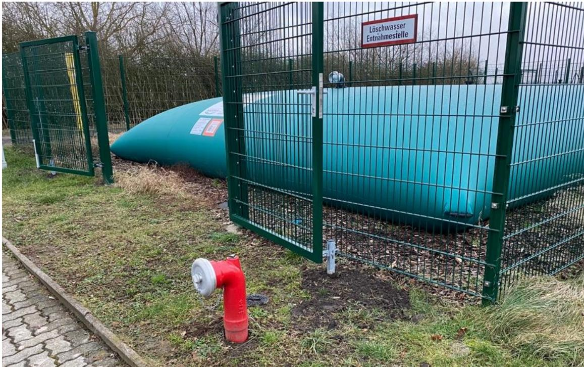
**Abbildung 2: unterirdischer Sauganschluss der mit dem Löschwasserbehälter verbunden ist, wodurch die Frostsicherheit erreicht wird.**
