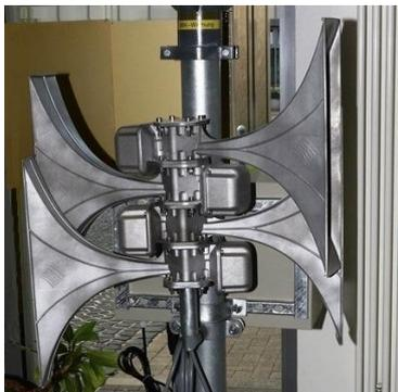
Bei diesem Sirenentyp wird der Warnton durch einen elektronischen Tongenerator erzeugt, dann verstärkt und über einen Druckkammerlautsprecher ausgegeben. Die Form der Lautsprecher führt zu dem typischen optischen Erscheinungsbild. Die Nachrüstung des Sprachmoduls ist bei der auf dem Verwaltungssitz verbauten Sirene möglich. Aufgrund der technischen Bauart wird davon ausgegangen, dass im Umkreis von 500 m um eine derartige Sirene der Schalldruck für den Weckeffekt ausreichen ist.
